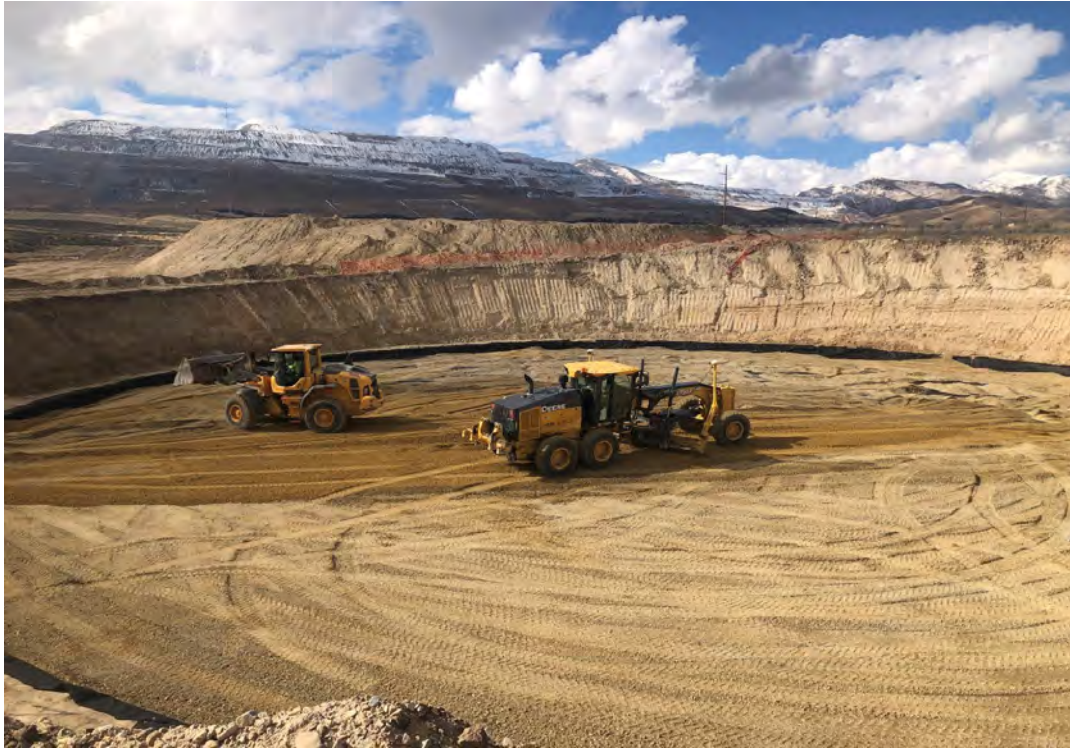
Installing structural fill
